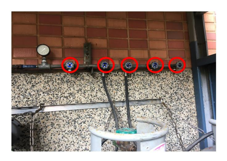
第5步:根據煤氣桶上綠色開關的標籤往開或關的方向轉動。 Step 5:Turn the switch on or off in the direction of the green switch on the gas tank.
